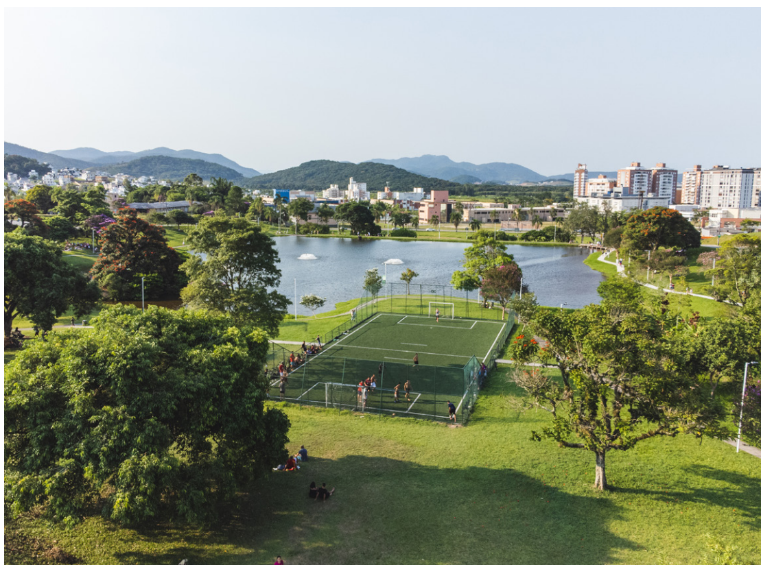
Lago Pedra Branca, elemento marcante da primeira fase do bairro. Na página anterior, a vista aérea da época em que havia apenas o campus da UNISUL na área.
